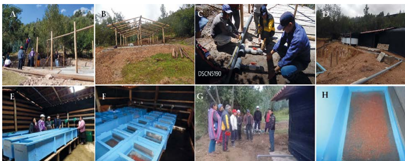
Figura 24.- Instalación, implementación y siembra de ovas embrionadas en el módulo de Quinoa. A) Plataforma para instalación del módulo. B) Instalación del techo. C) Instalación de tubería de agua. D) Módulo instalado. E) Prueba del ingreso de agua a los tanques. F) Siembra de ovas en tanques de incubación. G) Coordinaciones con los pobladores después de la siembra. H) Ovas embrionadas sembradas en canastilla
