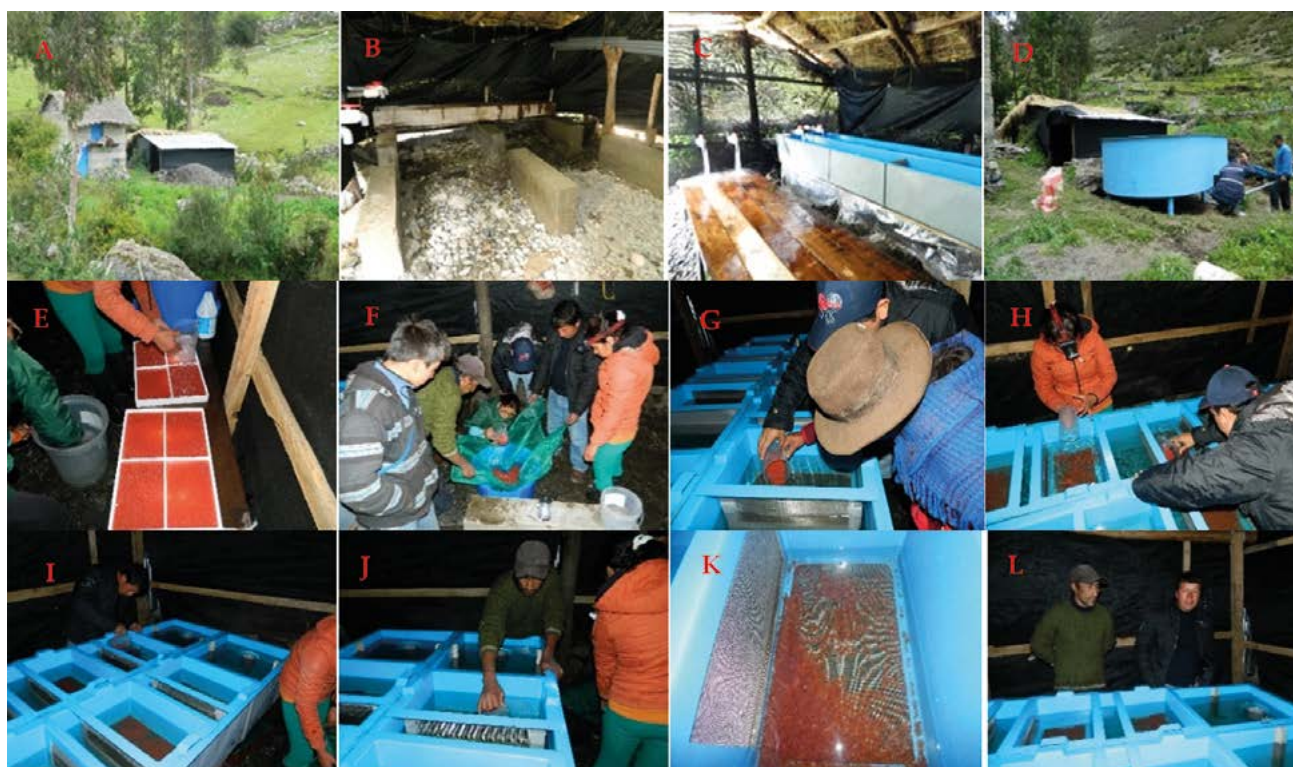
Figura 12.- Chungui: instalación, implementación y siembra de ovas embrionadas: A) Módulo de incubación de ovas y alevinaje de trucha. B) Instalación de camas de madera para colocación de tanques. C) Instalación de tuberías de ingreso de agua. D) Instalación de tanques. E) Hidratación de ovas para la siembra. F) Desinfección de ovas. G) Siembra de ovas. H) Supervisión de la siembra de ovas. I) Siembra de ovas. J) Extracción de exceso de ovas embrionadas de canastilla. K) Ovas sembradas en canastilla. L) Representantes de la Asociación del módulo de Chungui
