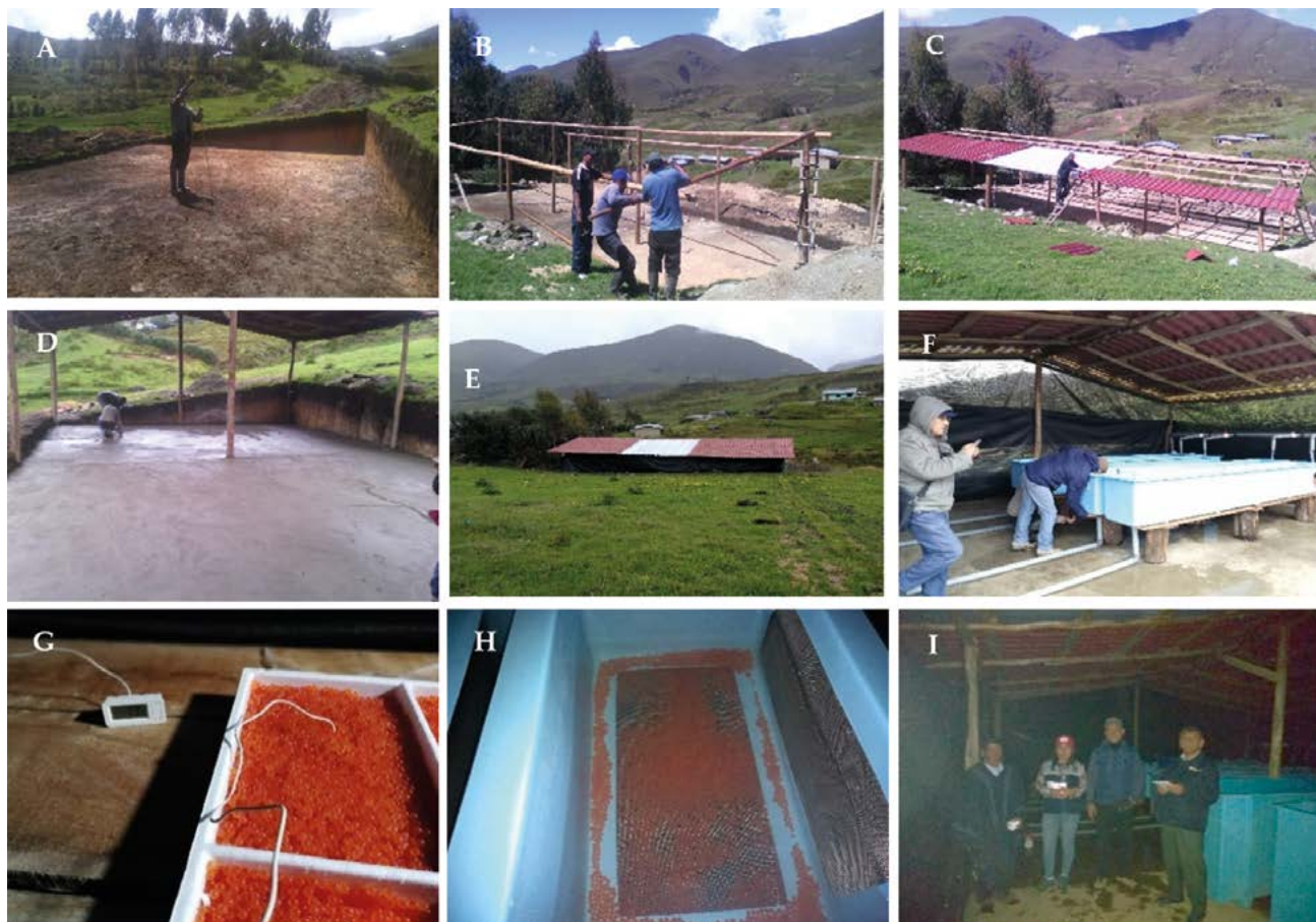
Figura 59.- Instalación, implementación y siembra de ovas embrionadas en el módulo de Huacrachuco. A) Corte del terreno para la construcción del módulo. B) Construcción de la estructura. C) Techado del módulo. D) Construcción del piso. E) Módulo terminado. F) Implementación del módulo. G) Medición de la temperatura de ovas. H) Siembra de ovas. I) Supervisión de Produce al módulo
