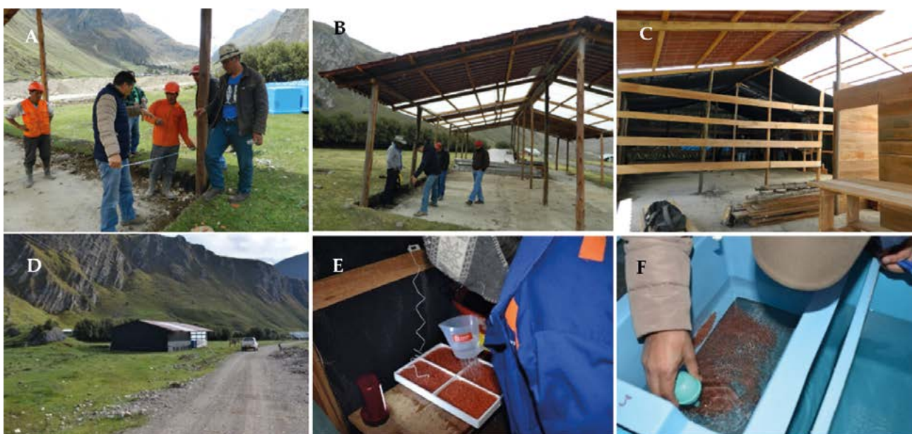
Figura 49.- Instalación, implementación y siembra de ovas en el módulo de Queropalca. A), B) Asistencia técnica para la instalación de tuberías de ingreso de agua e instalación de tanques. C) Construcción del almacén. D) Módulo instalado. E) Aclimatación de ovas embrionadas. F) Limpieza de ovas embrionadas
