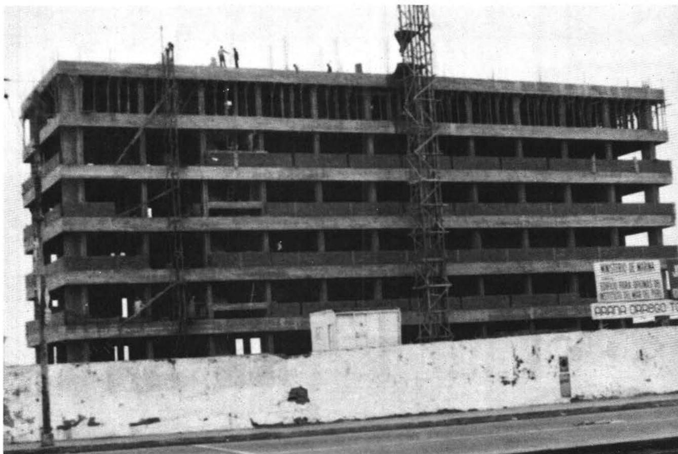
NUEVO EDIFICIO DEL INSTITUTO DEL MAR DEL PERU EN CONSTRUCCION
