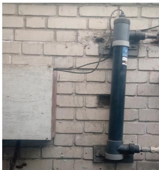
Figura 9.- Equipo UV, empleado en tratamiento del agua de mar
