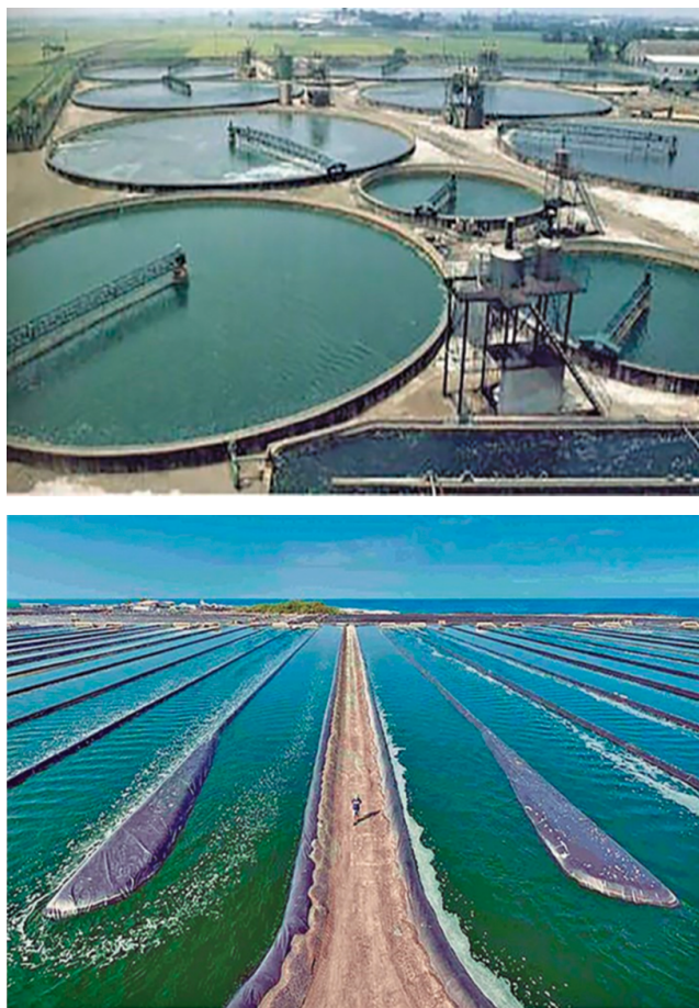
Figura 2.- Sistemas de cultivos abiertos: estanques circular y raceways
