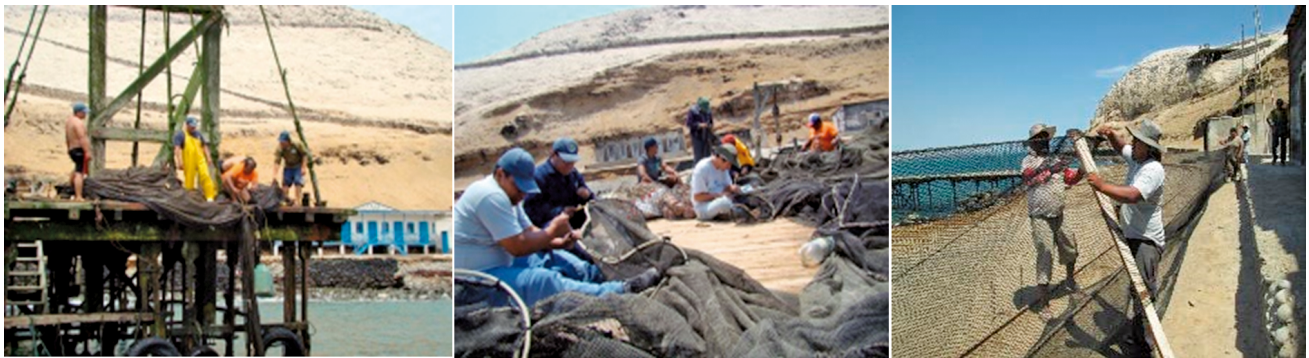
Figura 12.- Armado de cerco perimétrico
