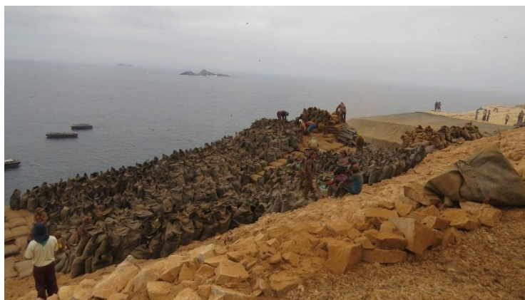
Figura 38: Los sacos llenos antes de ir a la zona de Zarandeo se agrupan en una cabria construida en la isla o punta explotada
