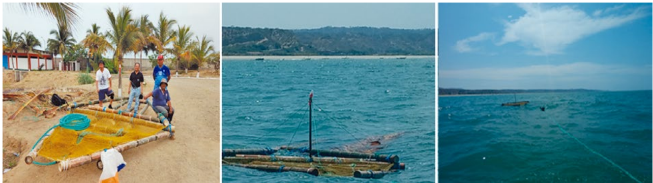
Figura 9.- DCP construido e instalado frente al Laboratorio Costero de Tumbes
