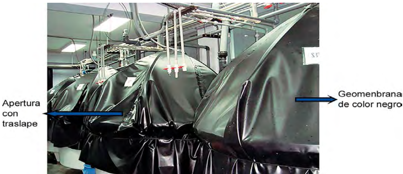
Figura 5.- Parte externa de tanque de cultivo, presentando: cobertor de geomembrana de color negro y abertura con traslape
