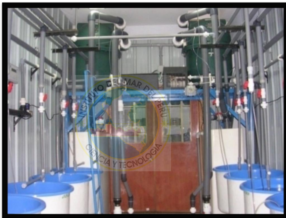
Figura 8. Sistema de recirculación de sala de larvas.
