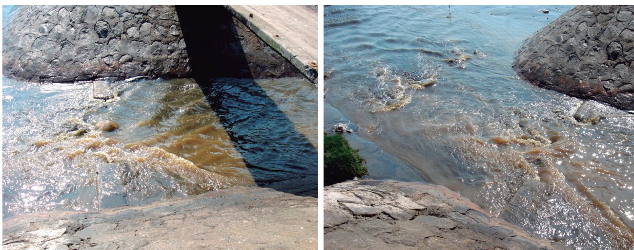
Figura 4.- Vistas de la desembocadura del Dren 4000
