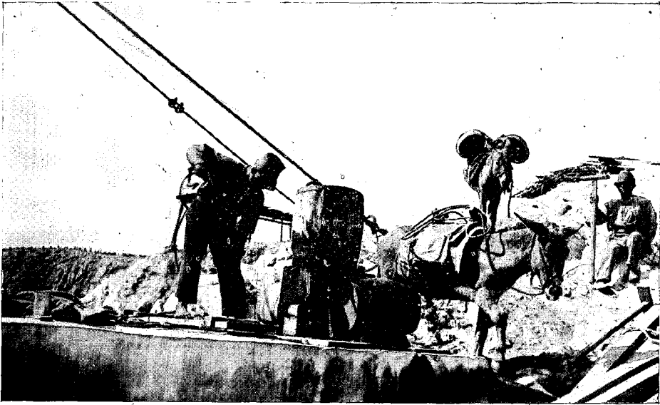
Fig. 2.—Extrayendo el agua de los tanques, de donde es conducida en burros a la pampa para su distribución a los braceros.
