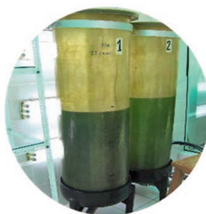
Figura 17.- Tanques de 250 L
