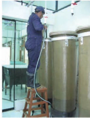
Figura 10.- Lavado de tanque.
