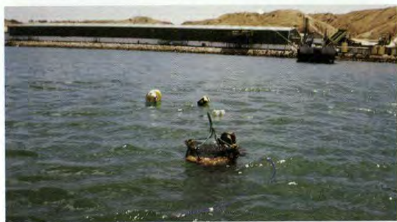
Instalación de los arreglos de linternas con moluscos bivalvos frente a las plantas pesqueras
